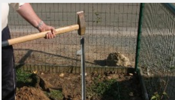
Bevestigen in de grond, dit kan ook met een boorhamer.
