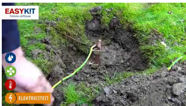
Aarding met aardelektrode of pin.
