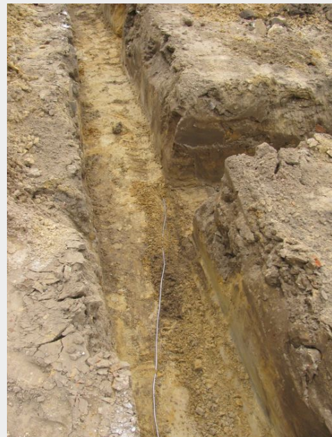
De funderingssleuf en de aardingslus
